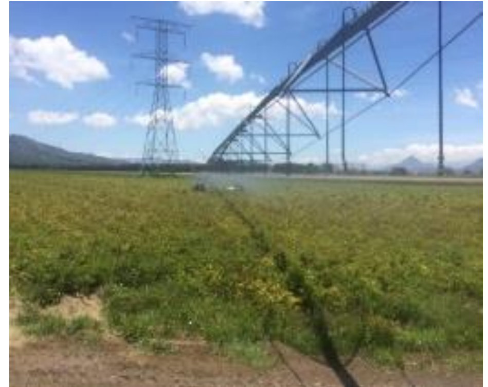
Figura 6. Derivación de tubería secundaria hacia los aspersores funcionado con el uso de la tarjeta electrónica.
